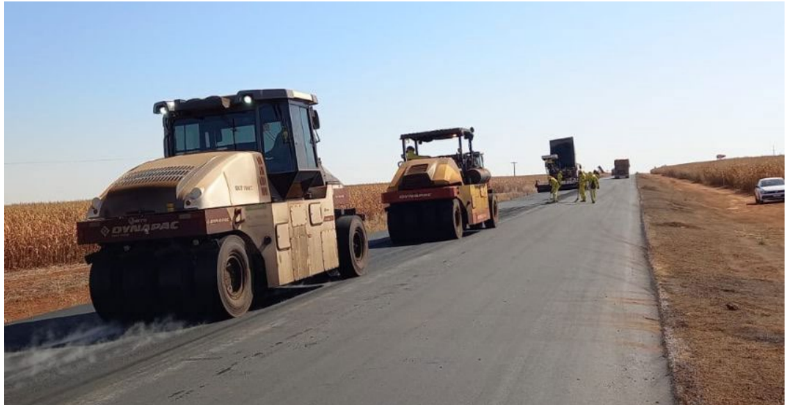
Equipes realizam serviços nas GOs 220 e 516: mais segurança, trafegabilidade e conforto para os usuários — Foto: Divulgação/Goinfra
