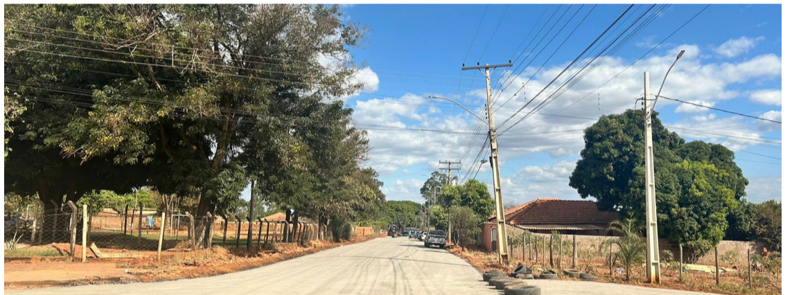
Pavimentação do setor Jardim das Oliveiras, concluída no dia 24 de junho — Foto: Reprodução.
